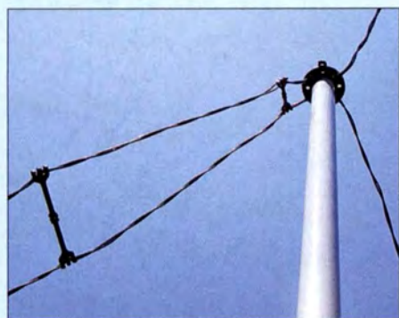
Bild 1: Mittelpunkt der Antenne am GFK-Mast, links die Zweidraht-Speiseleitung
