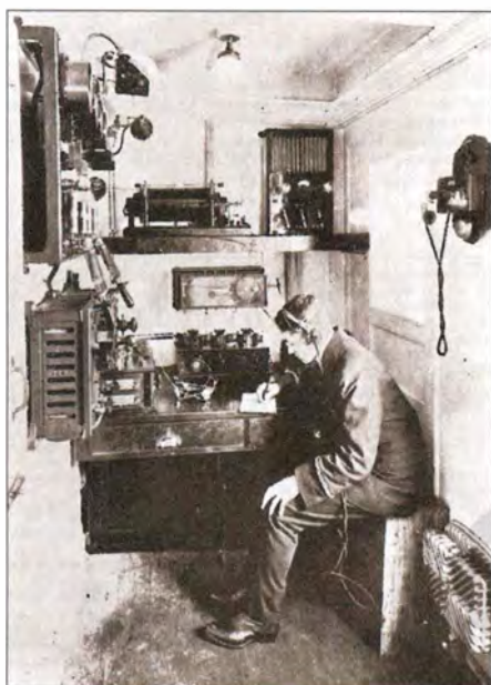
Typischer Funktelegrafie-Arbeitsplatz an Bord eines Schiffs; die erste Weltfunkkonferenz legte 1906 u. a. erste Regelungen für den internationalen Notfunkverkehr fest.
