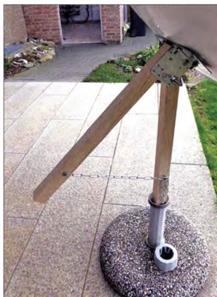
Bild 2: Träger der Parabolantenne in einem Sonnenschirmständer
